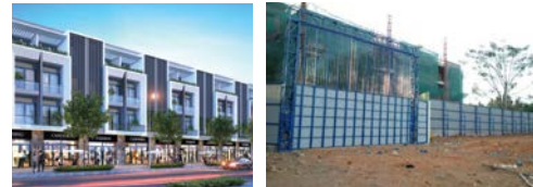
Công trường dự án Metro Valley.
